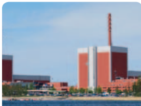
Kernkraftwerk Olkiluoto, Finnland 5
